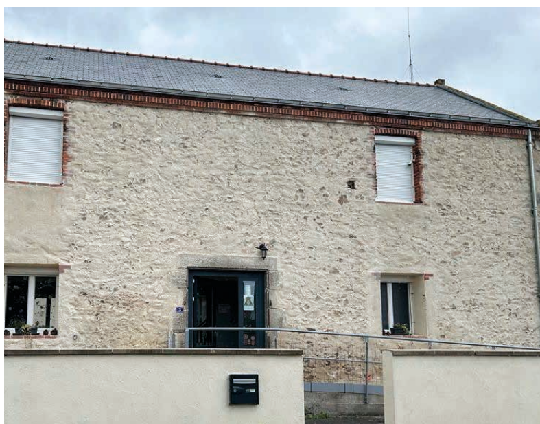
Le bâtiment de la MAM
