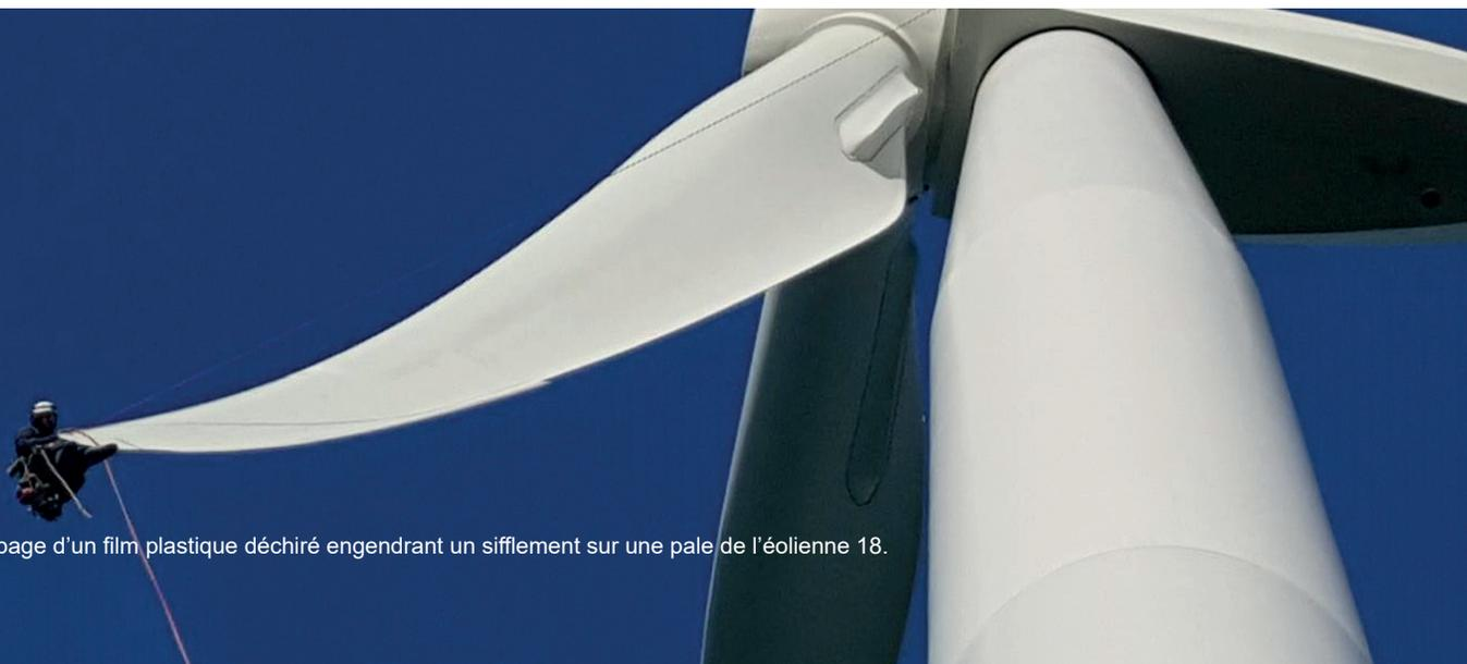
Novembre 2019 : découpage d'un film plastique déchiré engendrant un sifflement sur une pale de l'éolienne 18.
